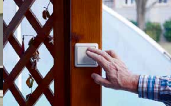
Bahçede kablosuz devreleme
