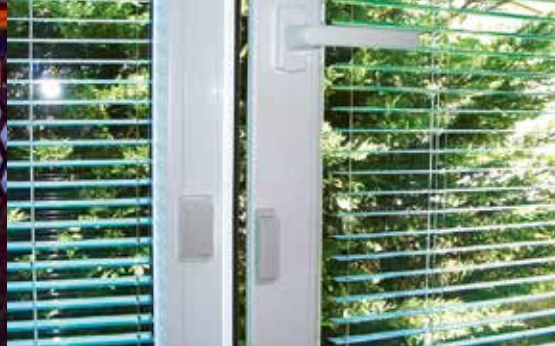
Siguranță cu comutatori radio cu magnet
